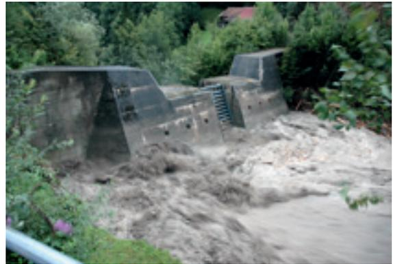
Betonflügeln und einer 4.5 m breiten Abflussöffnung, die mit waagrechten Stahlrohren (Durchmesser 40 cm, Abstand 12 cm) gesichert ist. Zuerst gibt es eine freie Öffnung von 2.25 m Höhe. Das unmittelbar anschliessende Tosbecken ist bachabwärts mit einer Gegenschwelle gesichert, die sich auf der gleichen Höhe wie die Einlaufschwelle der Abflusssperre befindet.
