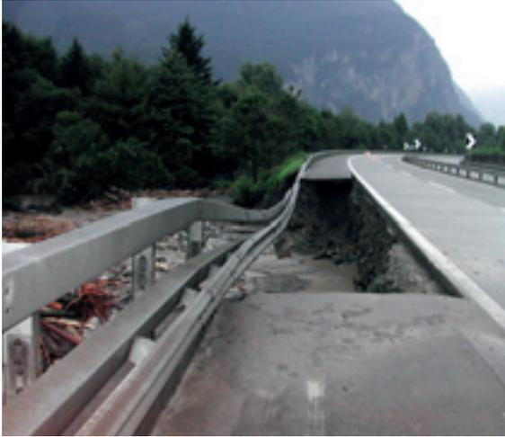
Abb. 31: Zerstörter Pannestreifen der A2
