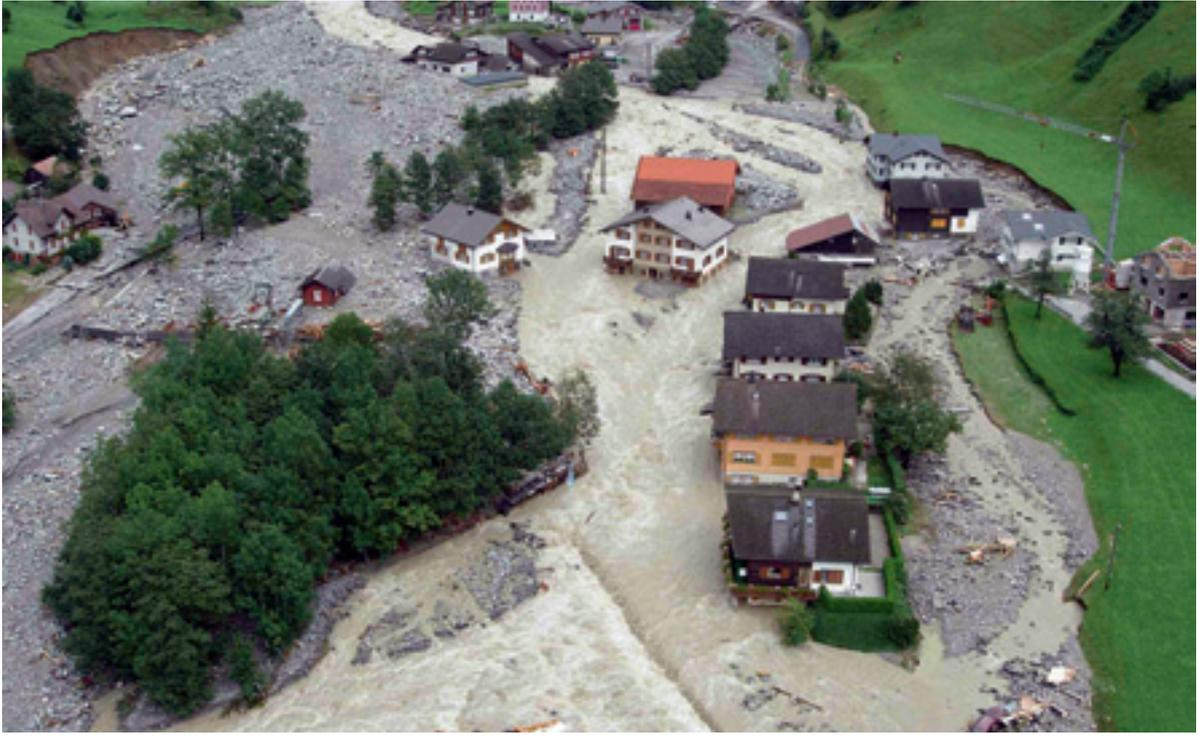
Abb. 4: Deichbruch am Schluchtausgang des Chärstelenbachs bei Bristen mit Verlegung des Flusses
