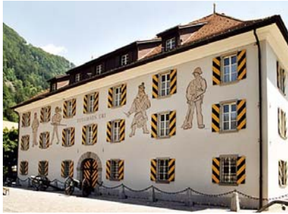
Das Kantonale Zeughaus mitten in Altdorf, neben dem theater(uri) als neues Haus der Volksmusik.
