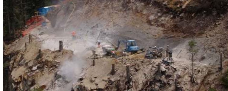
Hangsicherung mittels Felsnägeln und Gunit
