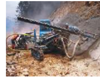
Bohren der Hangsicherung
