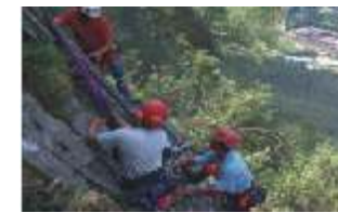
Montage des Bohrgerätes
