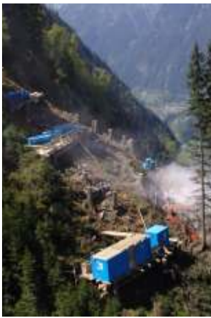
Installationsplatz 1400 m ü. M.
