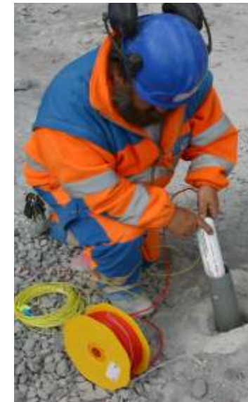
Laden des Bohrloches
