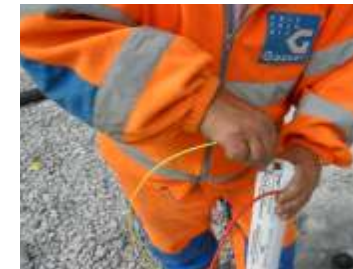
Vorbereiten der Sprengladung
