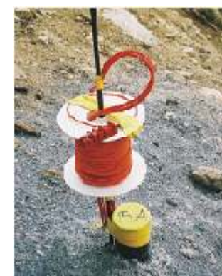
Bohrloch mit Zündschnur
