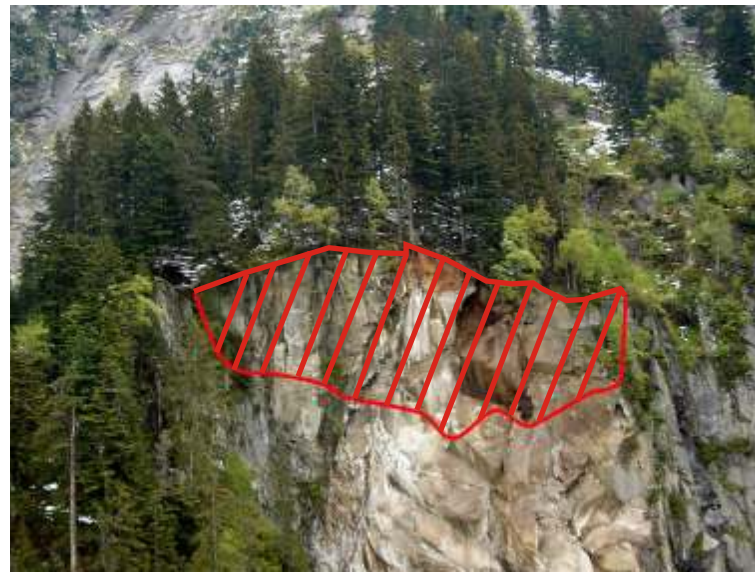
Felsabbruchstelle vor Beginn der Arbeiten mit Sprengperimeter
