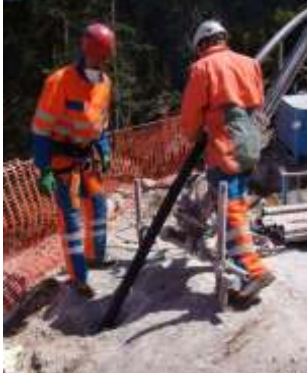
Bohrlochverrohrung
