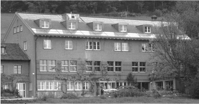
Herzberg, Haus für Bildung und Begegnung, Solarzellen (oben) und Sonnenkollektoren (unten) auf dem gleichen Dach, Bild ADEV Aarau
