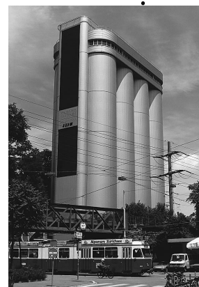
Stadtmühle CMZ, Zürich, Bild Coop Schweiz
