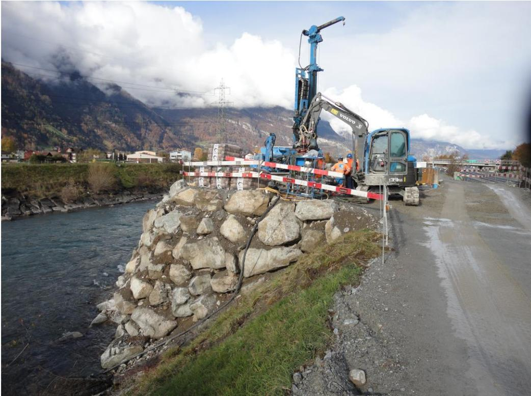
**Bild 2:** Temporäre Arbeitsplattform für den Bau der Mastfundamente entlang des Reussdamms.
