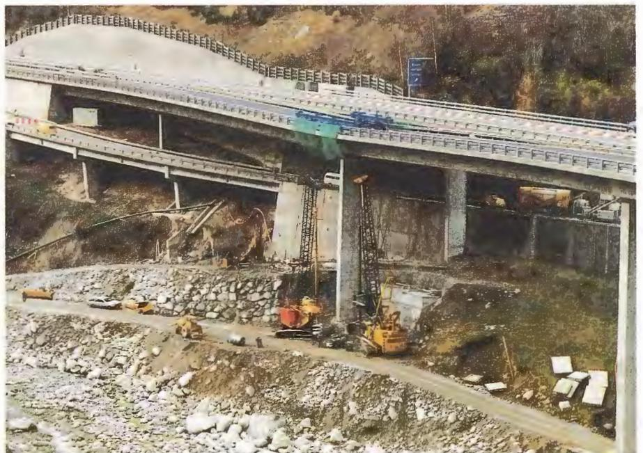
Bild 6. Übersicht Bohrpfahlarbeiten mit zwei Geräten bei Pfeiler I, November 1987
