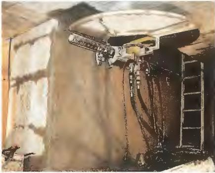
Bild 13. Bohr- und Fräsarbeiten am Pfeilerfuss für den Einbau des Gleitlagers
