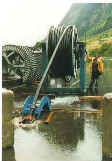
Bild 15. Vorspannung Überbau, Einziehen der Kabel
