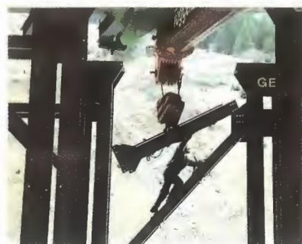
Bild 9. Montage der Querverstrebungen
