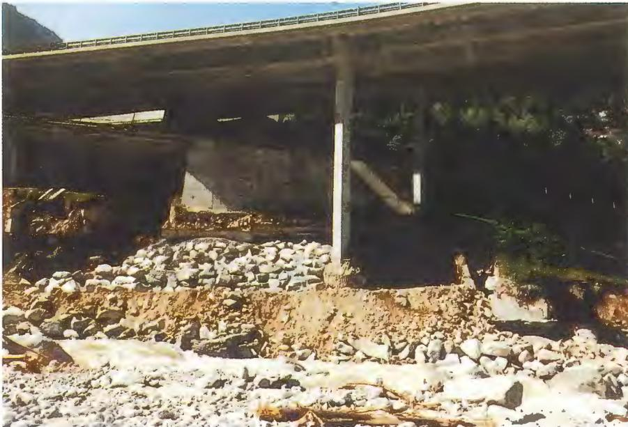
Bild 12. 15000 m<sup>3</sup> Stein- und Steinbruchmaterial; gelungene Unterstellung von Widerlager und Stützmauer am 29.8.1989, Mitternacht
