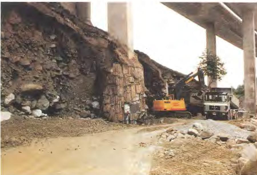
Bild 11. Umschütten der Schachtfundation Pfeiler I und Aufbau des Stützkörpers für Stützmauer
