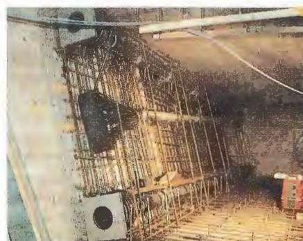
Bild 10. Brückentrog-Verstärkung, Vorspannung und Armierung
