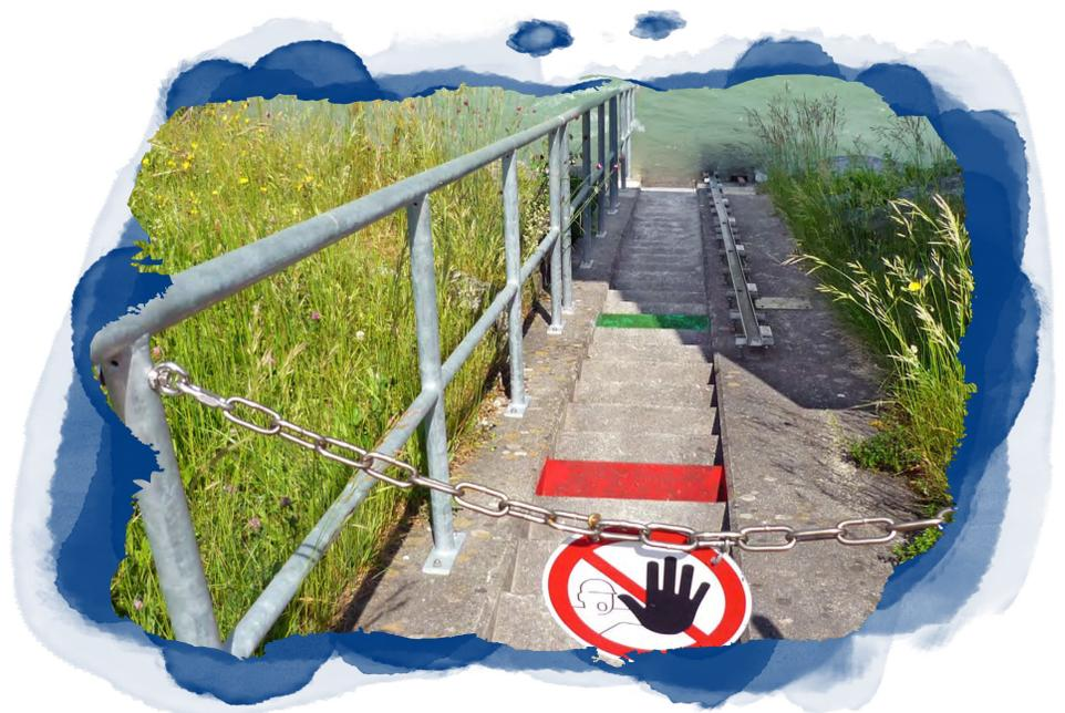
Die grüne Markierung bei der Treppe zeigt, bei welchem Wasserstand die Autobahn gesperrt wird, und die rote, wann das Wasser auf die Autobahn zu fließen beginnt.
