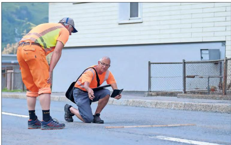
Beim Fahren spürt man sie kaum, doch Spurrillen können zur echten Gefahr werden. Ein Messstab auf der Strasse macht diese Rillen sichtbar.
