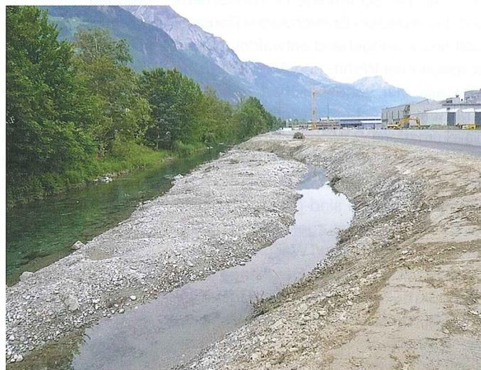
**Bild 2. Rechtsufrige Aufweitung an der Stillen Reuss (Foto Duwaplan).**
