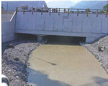
**Bild 3. Ansicht neuer Durchlass Stille Reuss unter dem Schächen hindurch.**
