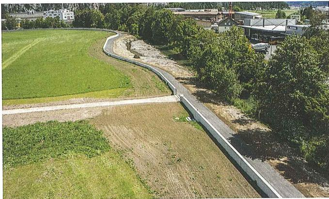
Bild 6. Schutzmauer mit Rad- und Gehweg.
