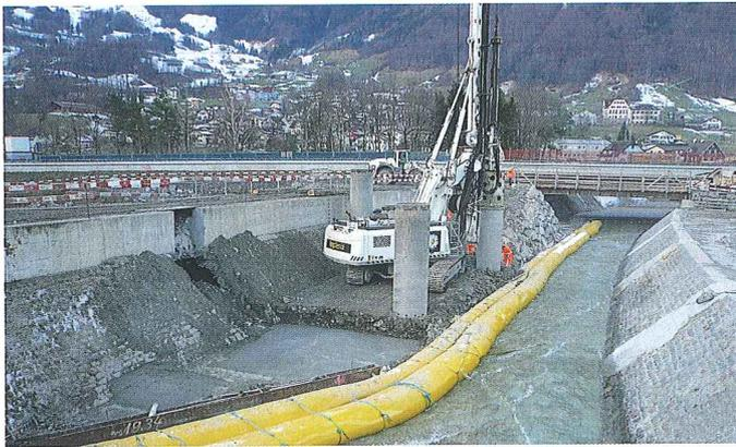
**Bild 1. Erstellen der Bohrpfähle im Schächen.**
