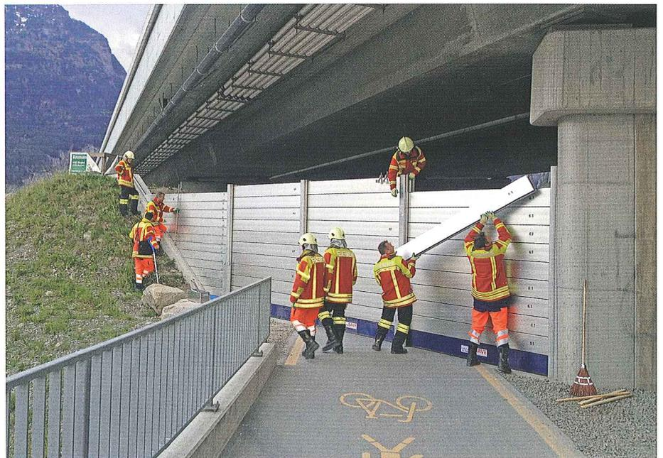
Bild 1. Einbau mobiler Dammbalkenelemente.
