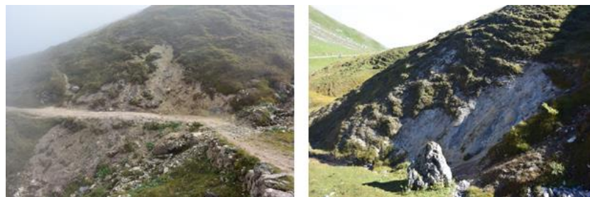
Abbildung 7: Rutschungen an den Fotostandorten 6 (links) und 11 (rechts).
