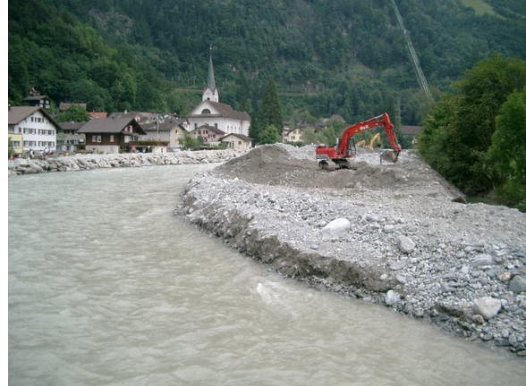
Foto 40; Geschieberäumung Reuss Amsteg (Kanton Uri, 25.08.2005)
