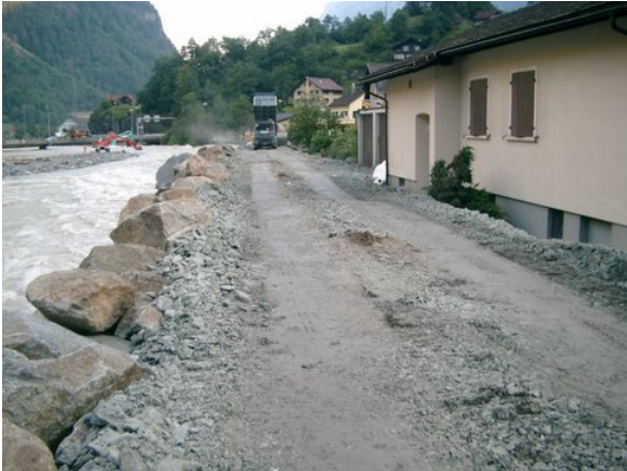
Foto 39; Prov. Uferschutz Reuss Amsteg (Kanton Uri, 24.08.2005)
