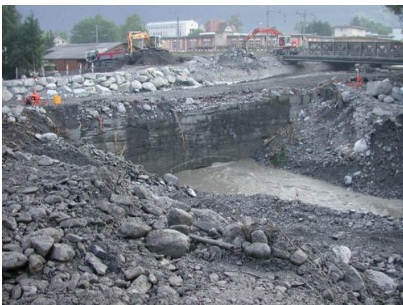
Foto 37; Unterführung Stille Reuss (Kanton Uri, 01.09.2005)
