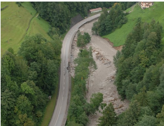
Foto 28; Klausenstrasse, Ennetschächen (Kanton Uri, 23.08.2005)
