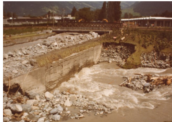
Foto 34; Unterführung Stille Reuss (Staatsarchiv, HW 1977)
