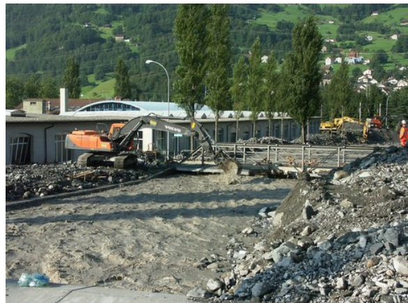
Foto 36; Baggereinsatz Bereich Fussgängerbrücke (RUAG, 24.08.2005, 08:07 Uhr)
