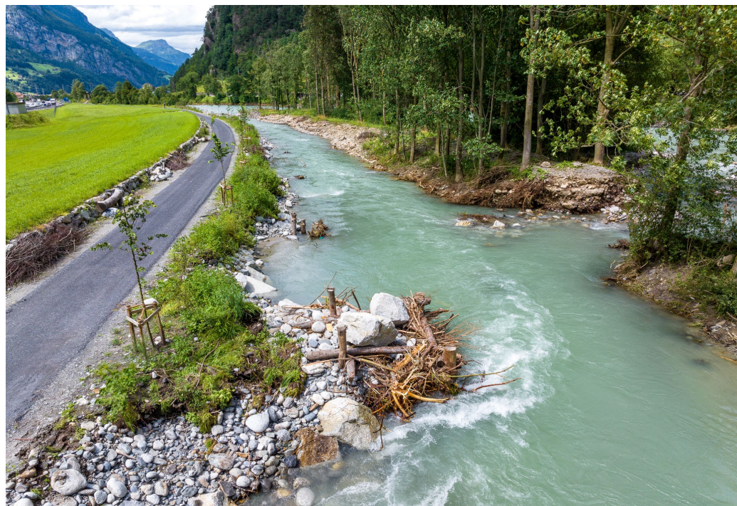
Abbildung 8: Seitengerinne mit strömungslenkendem Holzkasten
