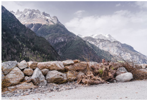
Abbildung 11: Trockensteinmauer mit Strukturstreifen
