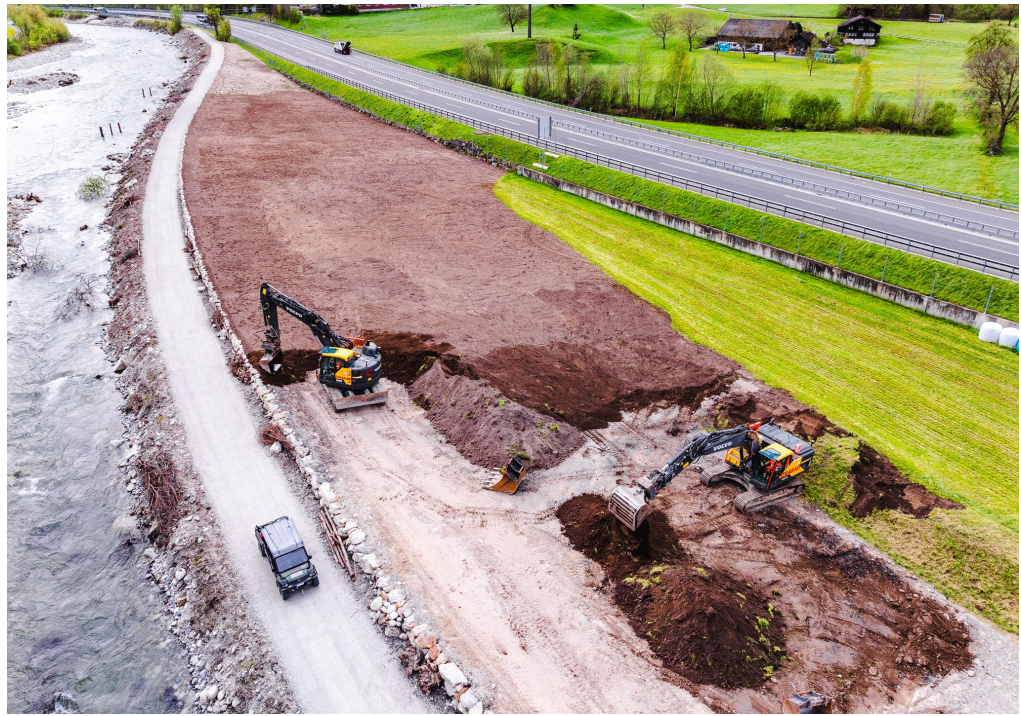
Abbildung 15: Anlegen von Ober- und Unterbodenmaterial
