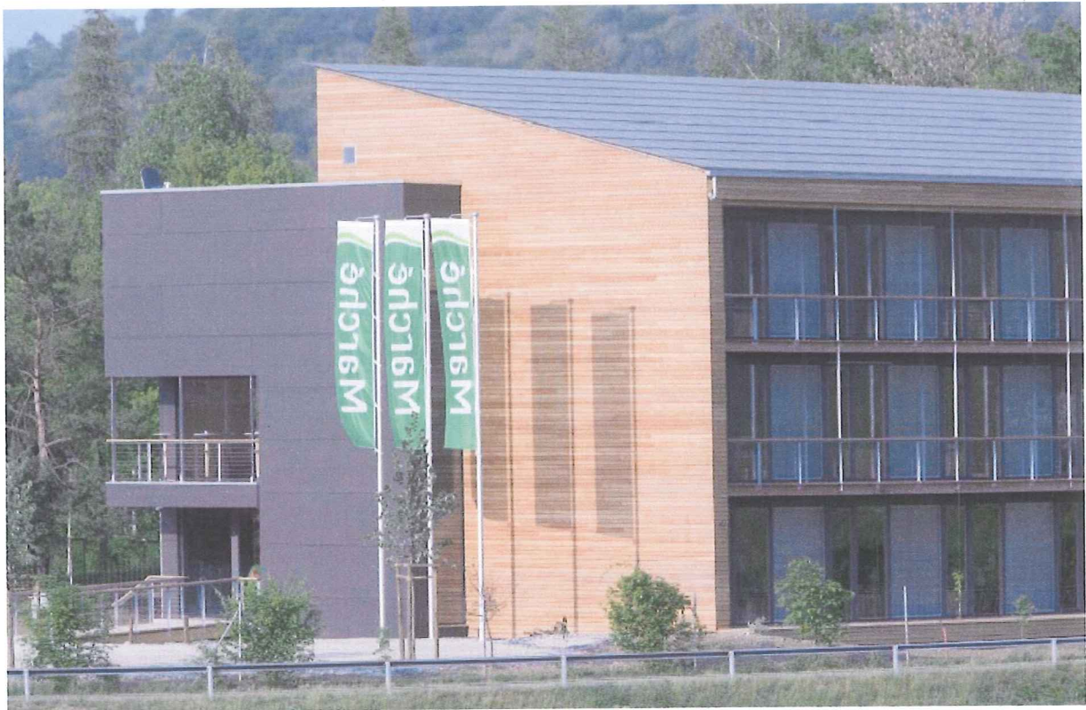
Verwaltungsgebäude des „Marché International“ in Kemptthal /ZH
