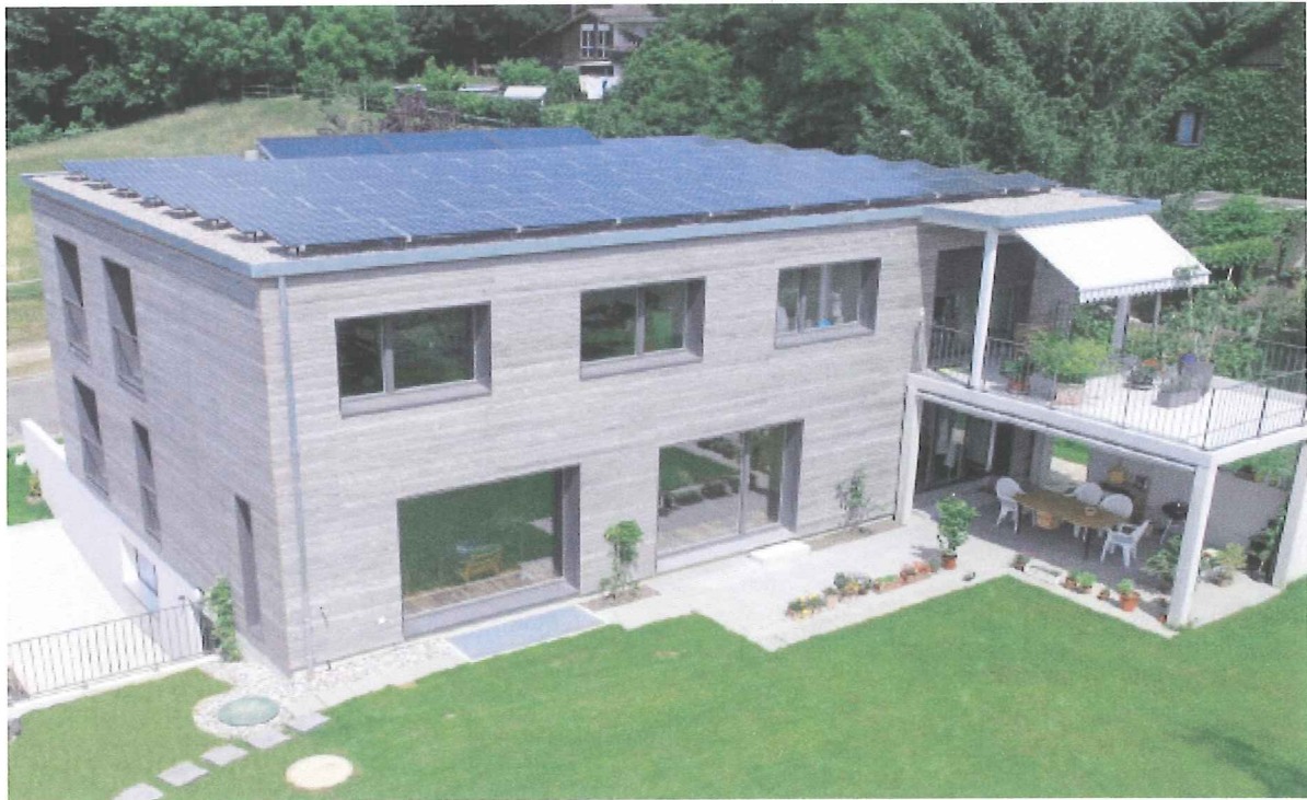
Plusenergiehaus in Riehen / BL
