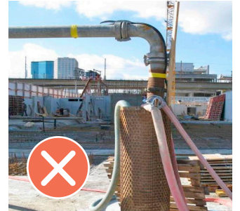
Keine Einleitung von Baugrubenabwasser ins Grundwasser!
