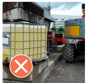
Auffangwanne fehlt, Abstand von Baumaschine zu gering
