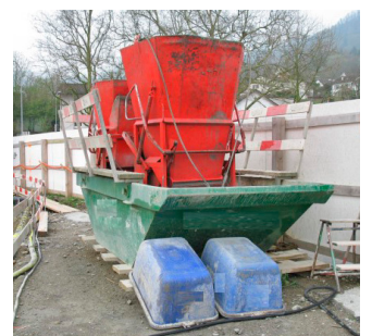
Beispiel Kübelwäsche über Mulde für die Rücknahme mit Betonfahrmischer
