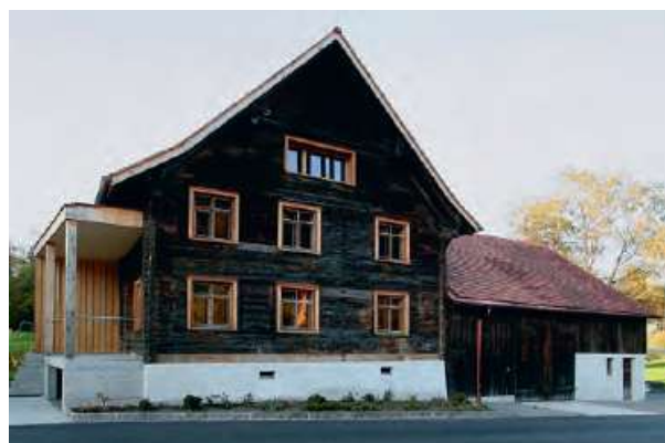
Gebäude nach der Sanierung
