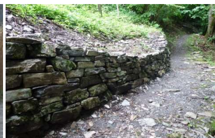
Sanierte Trockenmauer am alten Landweg in Bauen
