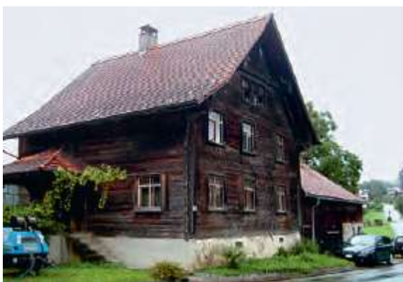
Gebäude vor der Sanierung
