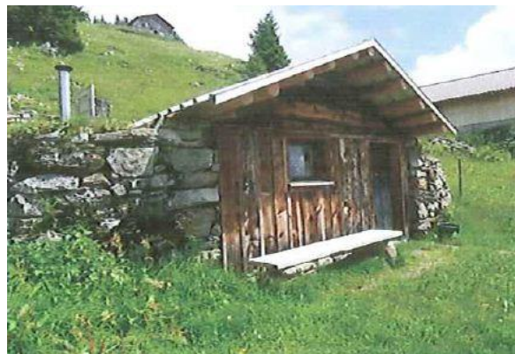
Sanierung und Teilersatzneubau
