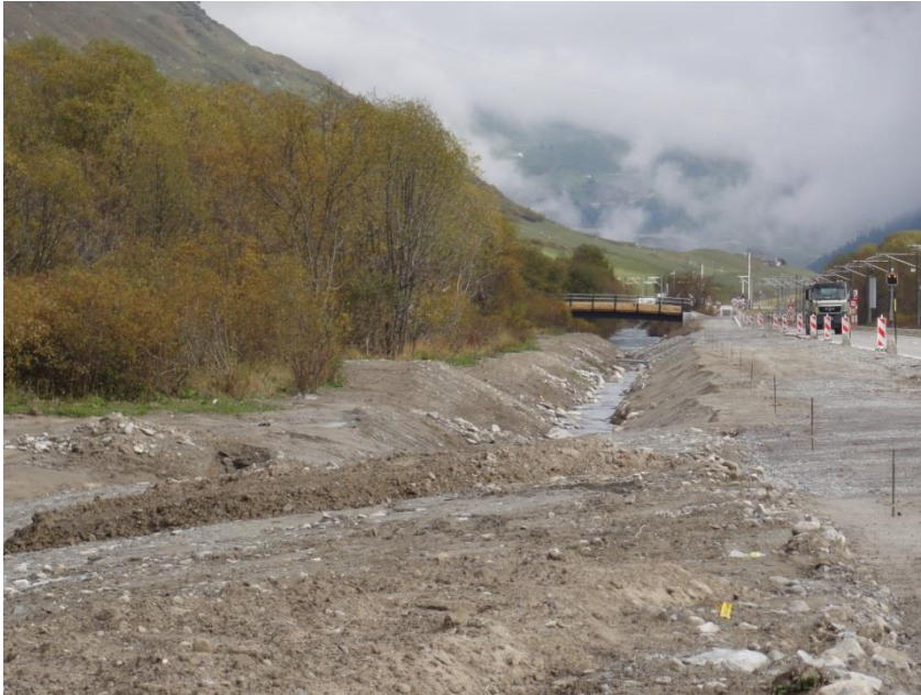
Der verlegte Fischgraben mit neu angelegtem Weg und der neuen Wanderwegbrücke über die Furkareuss (Foto AquaPlus)
