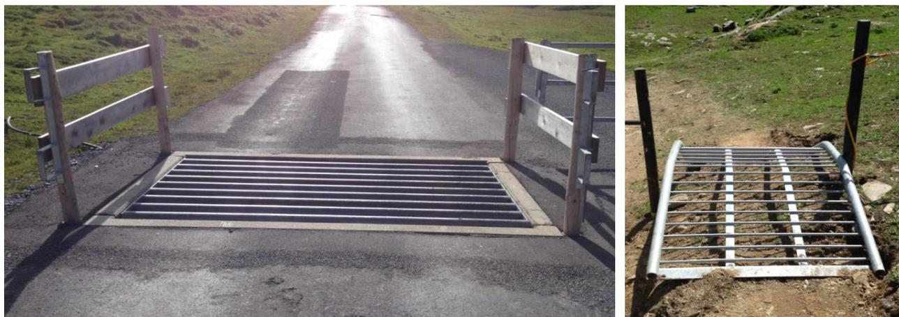
Weideroste eignen sich auf häufiger befahrenen Wegen oder Strassen durch Weiden mit Gross- und Kleinvieh. Die Passage auf dem zweiten Bild bewährt sich insbesondere bei häufiger Nutzung durch Fahrradfahrer.
