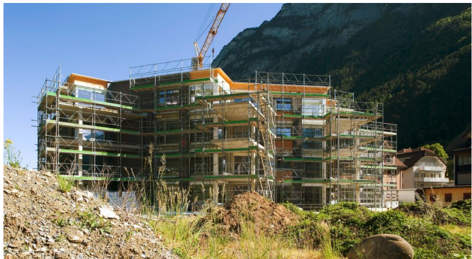
Abbildung 23: Baustelle eines Mehrfamilienhauses Erstfeld
