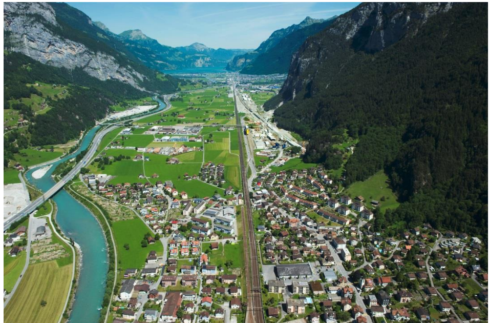
Abbildung 3: Luftaufnahme von Erstfeld Richtung Norden
