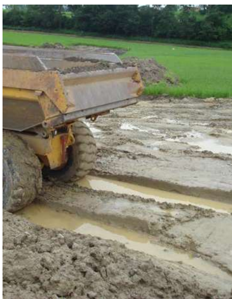
Die tiefen Fahrspuren zeigen es: Hier wurde der Boden bei nassen Verhältnissen mit einem zu schweren Gerät befahren.
