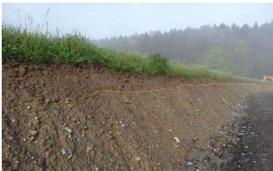
Gelungenes Beispiel einer Rekultivierung: Die gestrichelte Linie markiert die Grenze zwischen Unter- und Oberboden.
