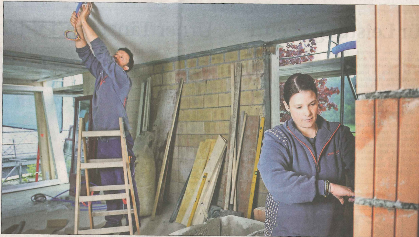
Der Silenerin Melanie Gisler macht es nichts aus, mit Männern zu arbeiten. Die Elektroinstallateurin ist mit diversen Urnern im Arbeitsteam.
