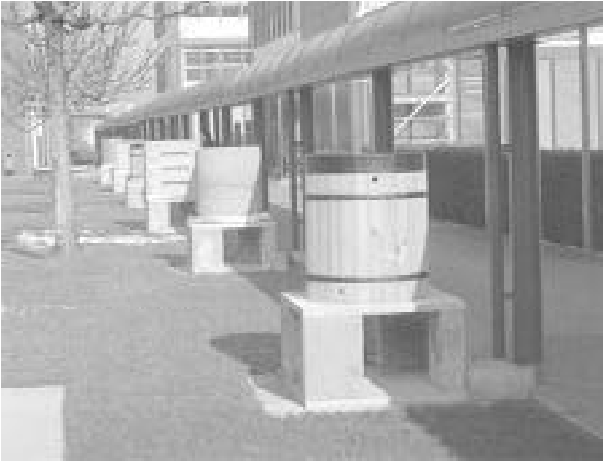
Blick auf die Regenwasserspeicher längs des Verbindungsganges.
