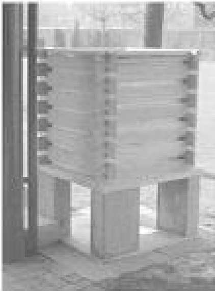
Regenwasserspeicher aus Holzbrettern und Kunststoffolie.
