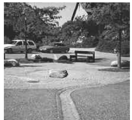
Das Platzwasser fliesst sichtbar und erlebbar in Rinnen !
