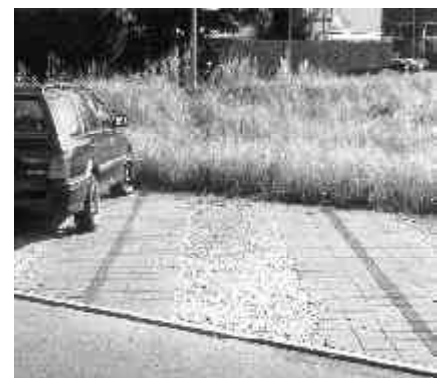
Das Regenwasser der gesamten Überbauung fliesst in den Weiher und von dort via Überlauf (Bildmitte) in die humusierte Geländemulde.
