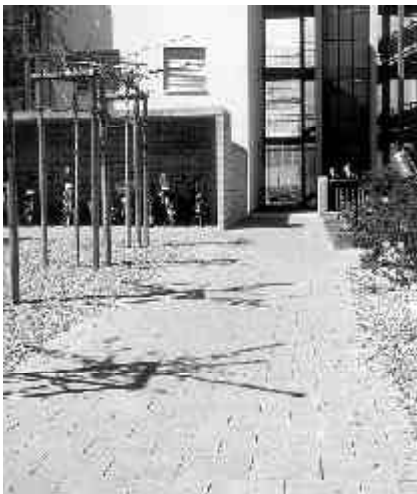
Poröse Pflastersteine (Ökosteine) lassen das Regenwasser direkt in den Untergrund versickern.
