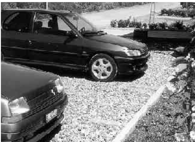
Auf den Parkplätzen kann das Regenwasser direkt versickern. Ideale Oberflächenmaterialien sind: Schotterrasen, Kiesflächen oder durchlässige Betonsteine.
