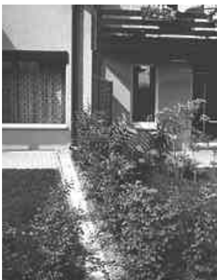
Das Dachwasser fließt in der offenen Abflussrinne aus Betonsteinen.
