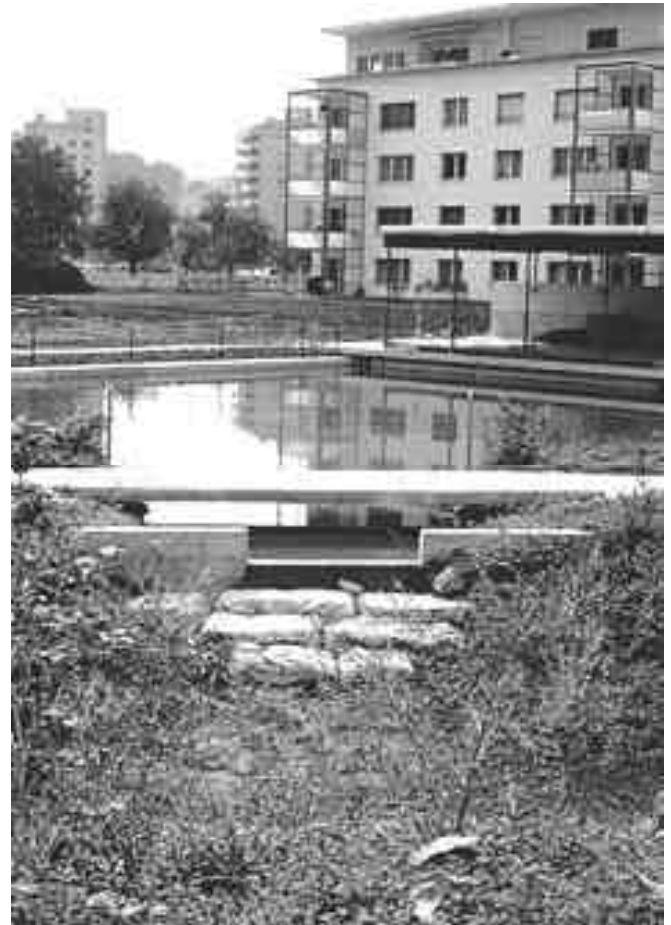
Das Regenwasser der gesamten Überbauung fliesst in den Weiher und von dort via Überlauf (Bildmitte) in die humusierte Geländemulde.
