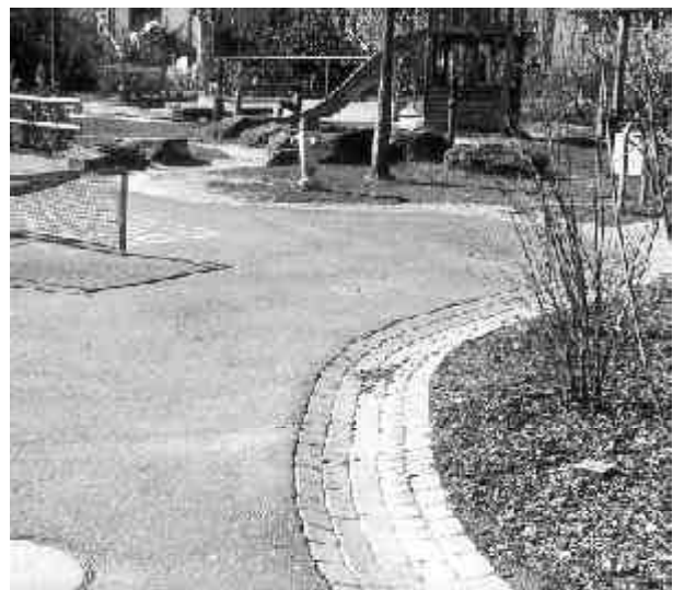
In der offenen Abflussrinne wird das Dachwasser quer durch den Kinderspielplatz geführt
