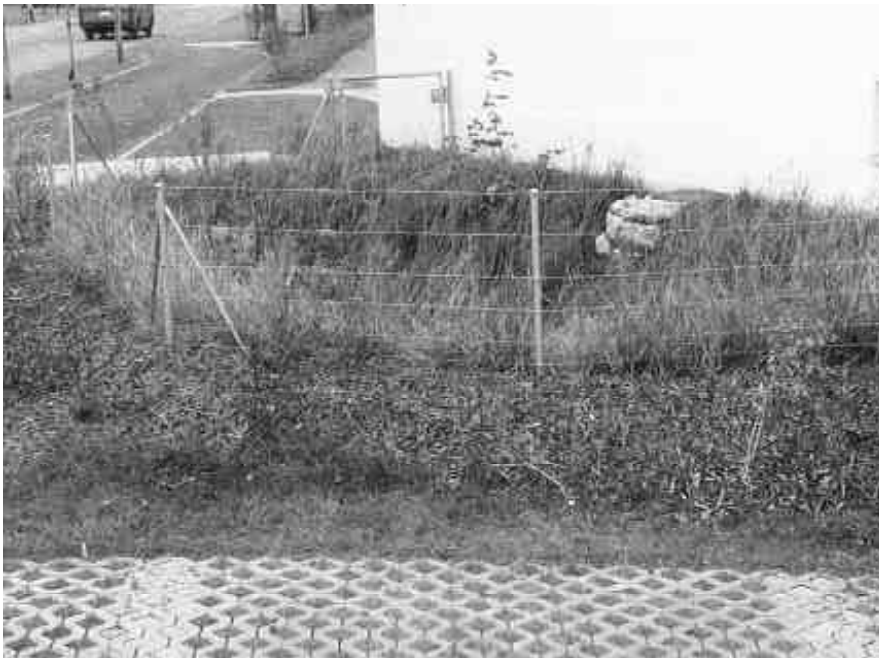
Das Dachwasser wird bei Gewitterregen in der begrünten Mulde gespeichert, bevor es langsam versickert.
