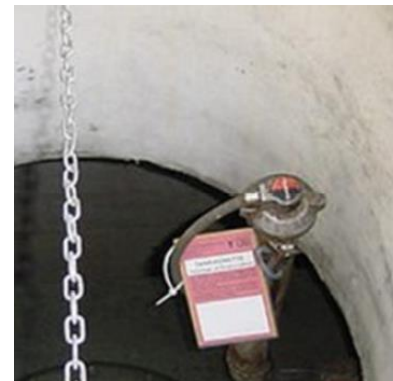
Laminierte Vignette im Domschacht eines erdverlegten Tanks
