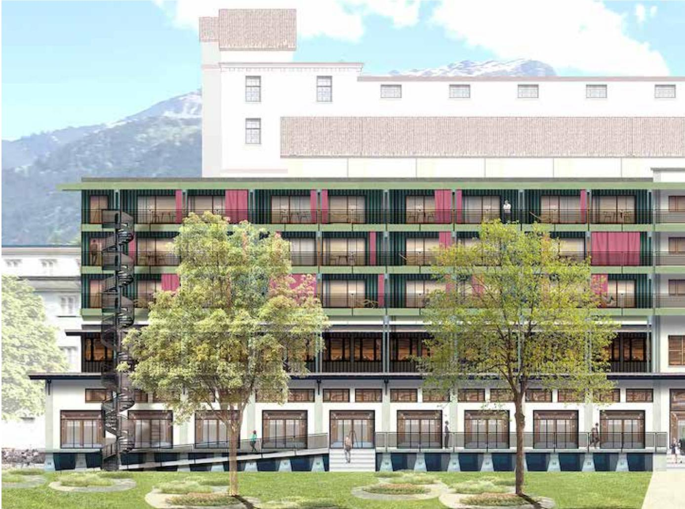
Die bestehende Flachlagerhalle 2 auf dem Baufeld 9 soll umgenutzt und mit 3 Geschossen erweitert werden. Der 3-geschossige Neubau aus Holz wird wie ein Tisch mit genügend Zwischenraum über das bestehende Gebäude gestellt. Eine minimale Anzahl von Stützen durchdringen die seitlichen Flügel der Flachlagerhalle.
