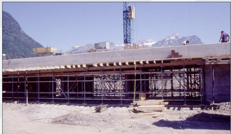
Der Durchlass im Bau
