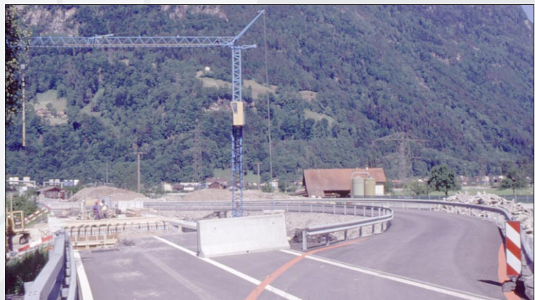
Provisorische Verkehrsführung während der Bauarbeiten
