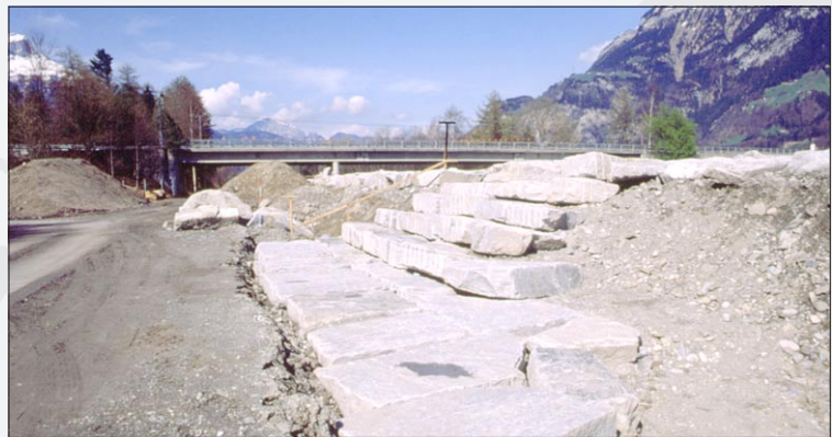
Die Kaskaden während der Bauarbeiten
