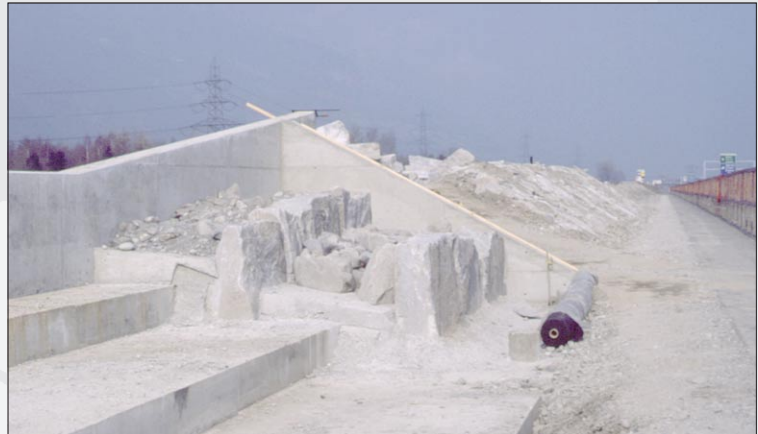
Die Hochwasserentlastungsanlage im Bau
