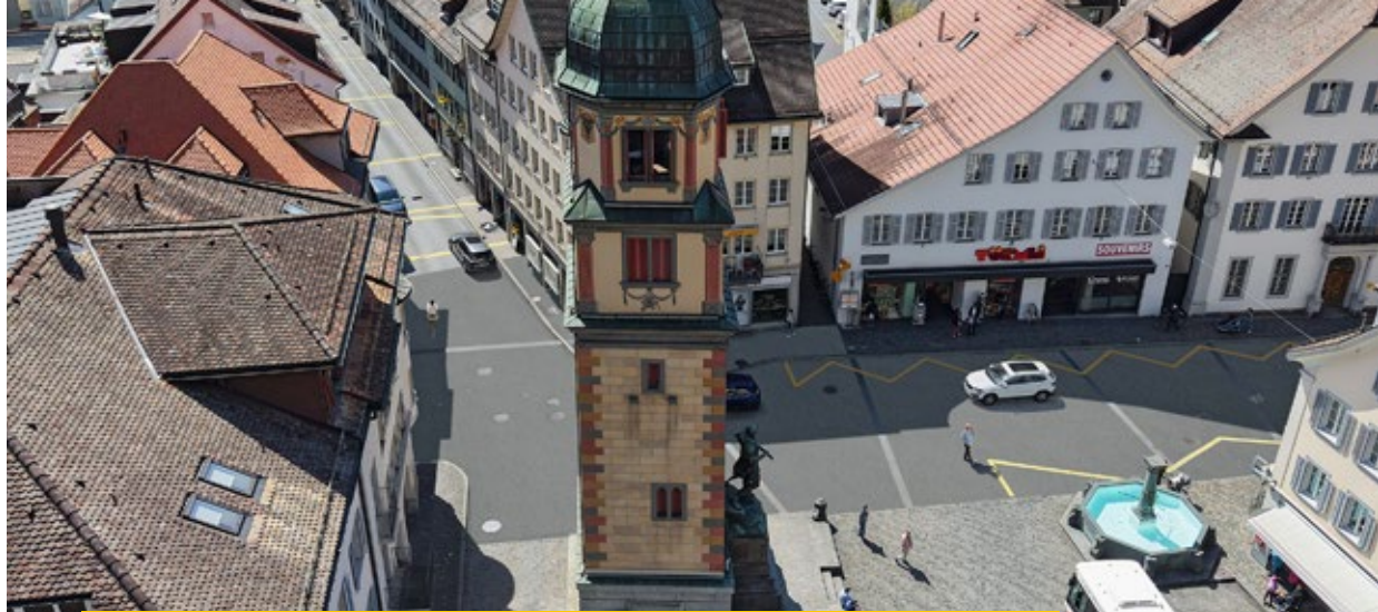
Im Zentrum von Altdorf entsteht eine Begegnungszone.
